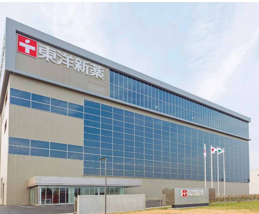
インテリジェンスパーク第1工場の外観
